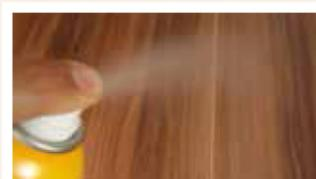
**6) Versiegeln:** Um die reparierte Stelle vor Staub und Schmutz zu schützen, die Stelle mit König Ansatzlos PLUS versiegeln. Glanzgrad entsprechend der Oberfläche wählen.
